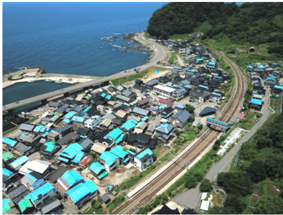
図2. 小岩川地区の被害状況（ドローンによる空撮）。
