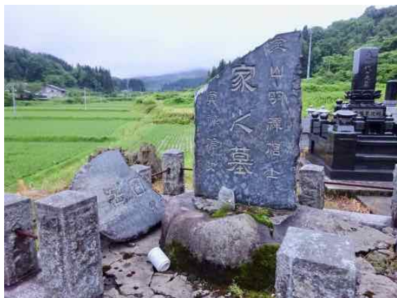
図8. 新潟地震の時に転倒破断し接着修復されていたが、今回の地震により上部が崩落した墓碑（宝伝寺）。
