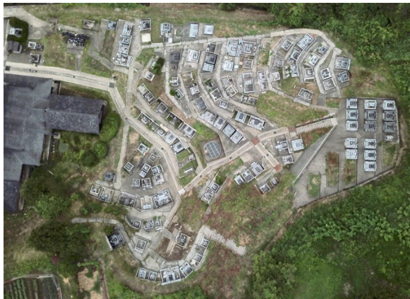
図4. 冷泉寺墓地全景（ドローンによる空撮）。 中央に地すべり防止用の集水井がある。 墓石転倒は画面上部の尾根状の地形に認められた。
